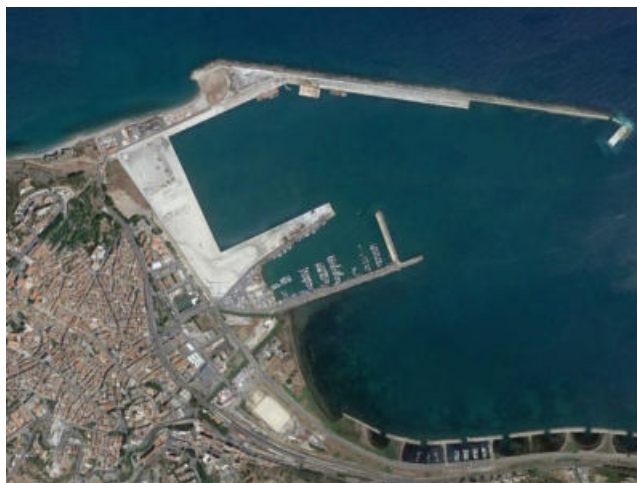
Figura 19 - Vista da satellite del Porto di Termini Imerese; fonte: Google Maps
